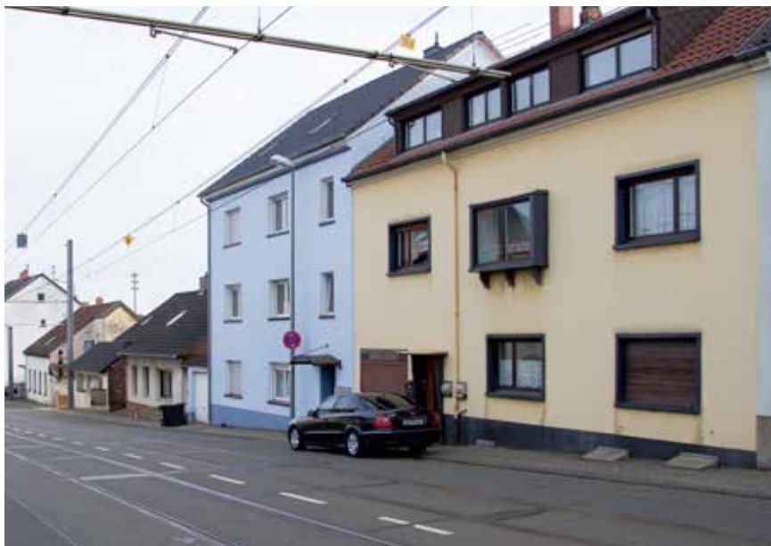
Sanierungsbedürftiges Gebäude in der Saarbrücker Straße
