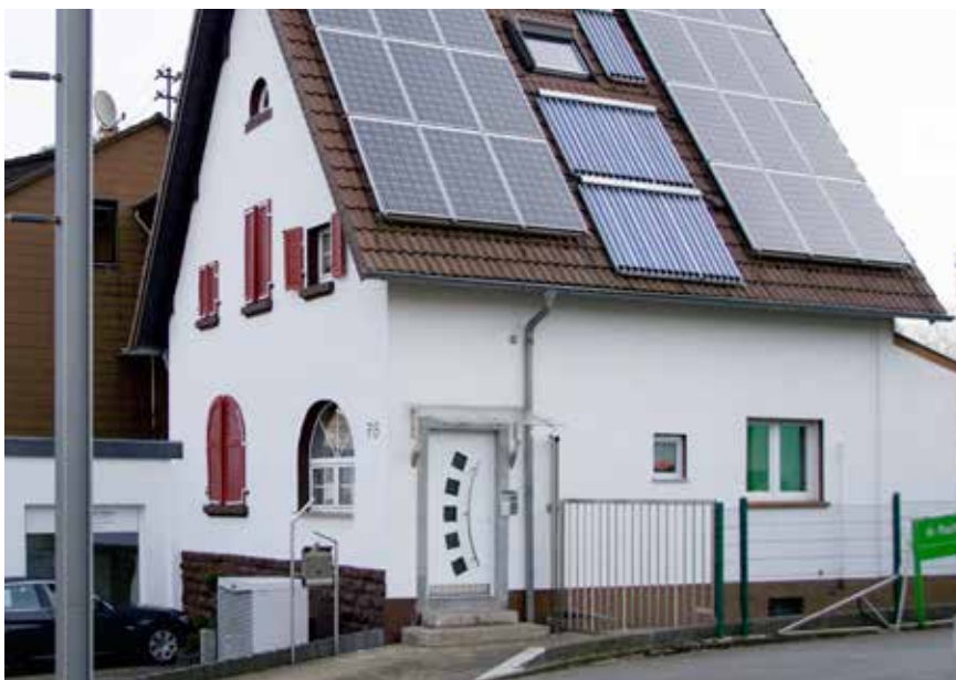
Modernisierungs- und instandsetzungsbedürftiges Gebäude mit geringem Bedarf
