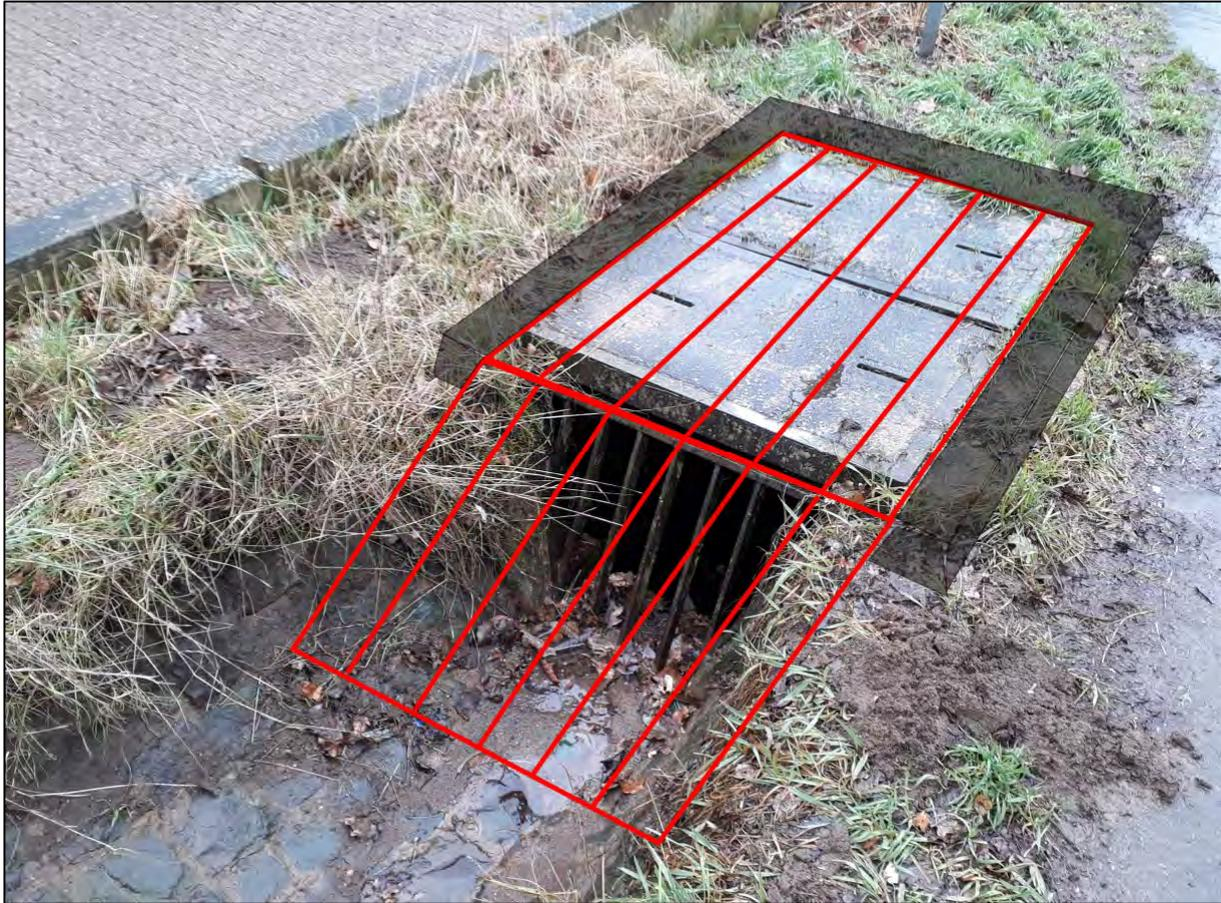
Abbildung 37: Visualisierung Neugestaltung Einlaufbauwerke
