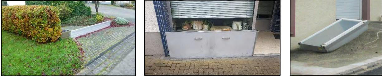
Abbildung 22: Beispiele von Objektschutzmaßnahmen (mobile Steckelemente, Dammbalkensysteme, Abdichtungen)
