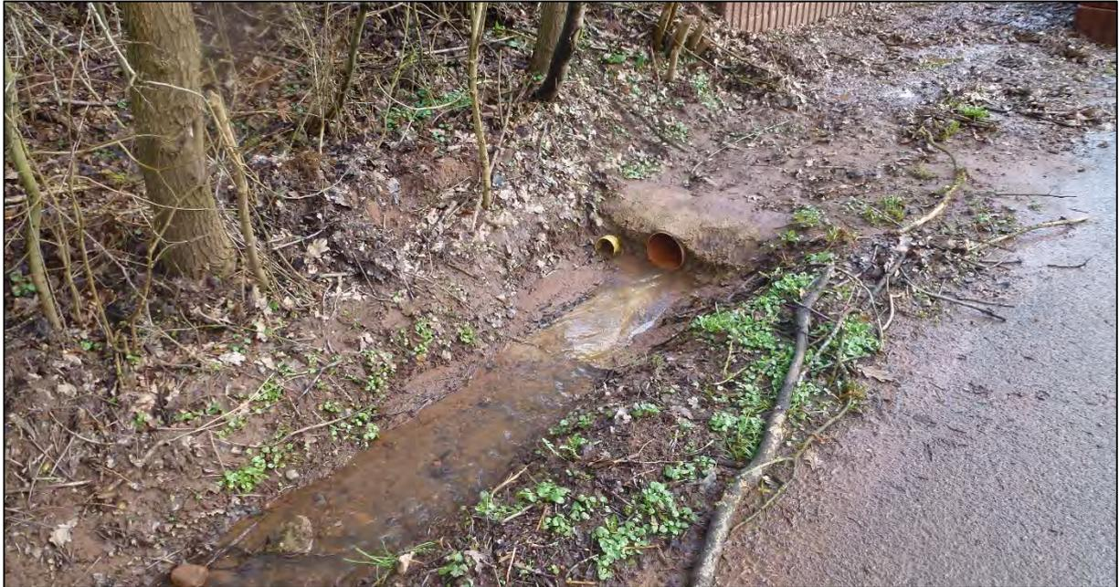
Abbildung 99: Durchlass zu gering dimensioniert
