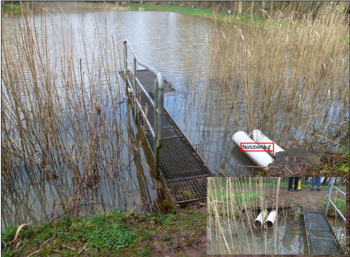
Abbildung 90: Mönchbauwerk und Notüberlauf
