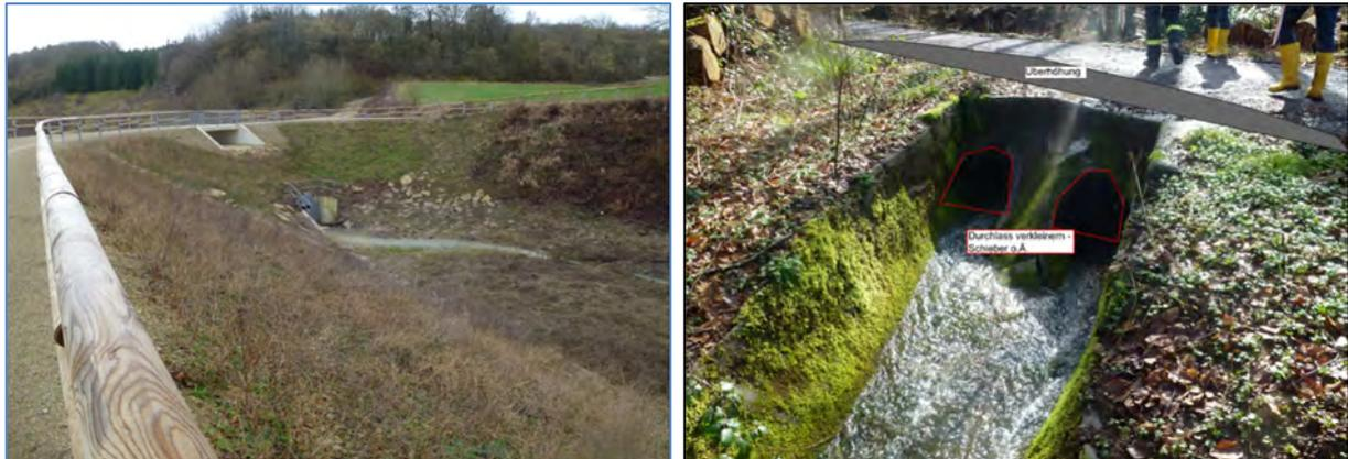
Abbildung 46: Beispiel Hochwasserrückhaltebecken (links), Verkleinerung der Durchlässe (rechts)
