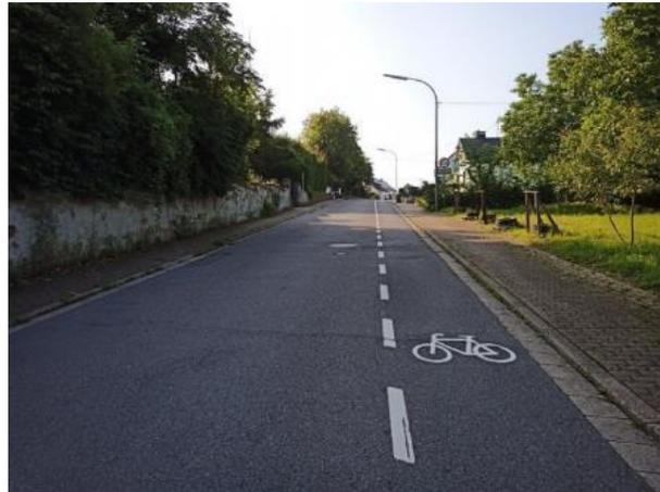
Abb. 13 Prinzipskizze eines alternierenden Schutzstreifens
